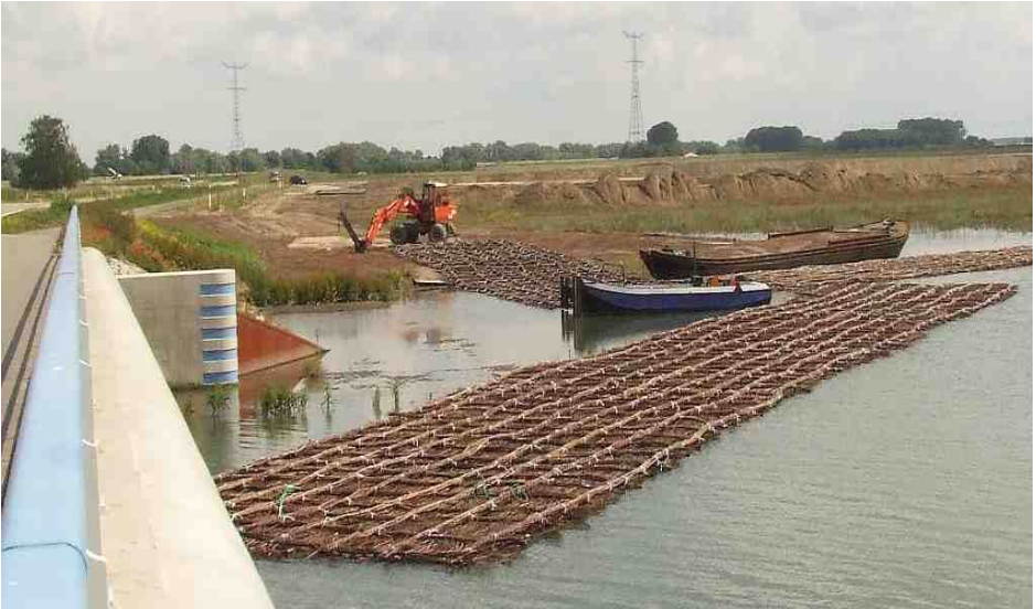
Nieuwe zinkstukken bij de aanleg van waterwerken in de Noordwaard bij Werkendam met een werkbootje en de typische platte dekschuit, waarop wilgentakken en rijshout worden aangevoerd. Foto: Ankie Stoop, 15 juni 2008
